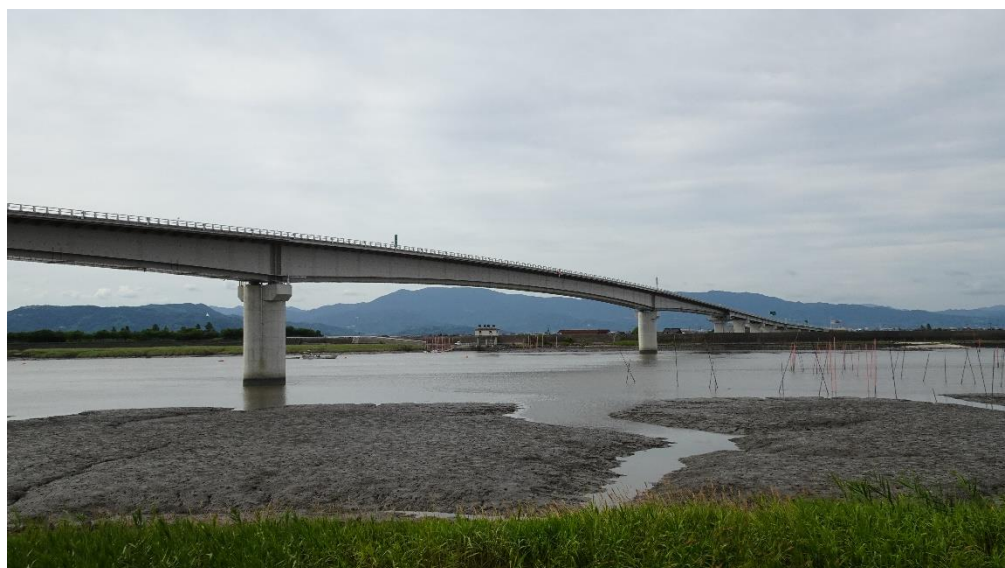
7月24日開通の有明沿岸道路（芦刈南 IC～福富 IC 間）
